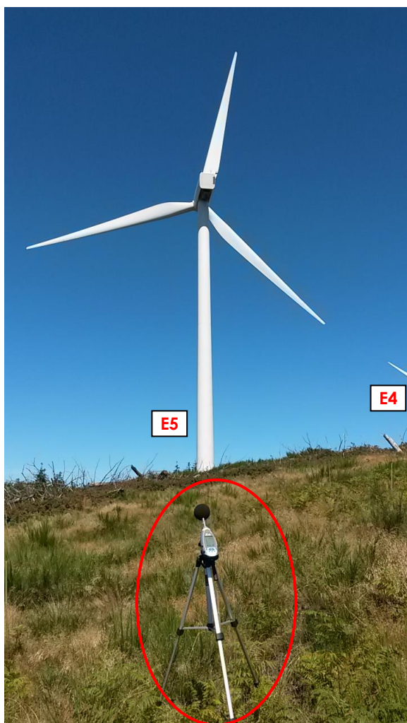
Photographie 6. POINT NO : sur le périmètre de mesures
